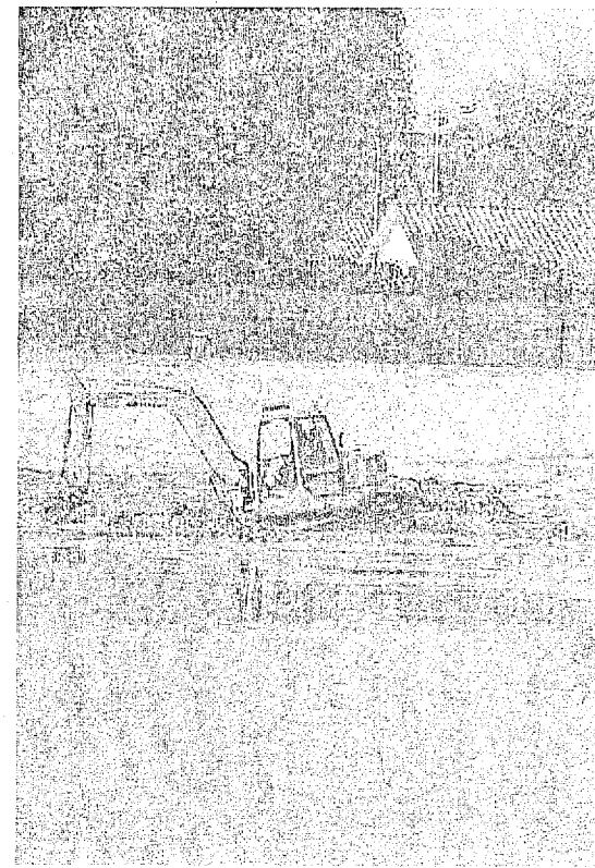
Perugia. Operazioni di bonifica sulle sponde del Trasimeno
